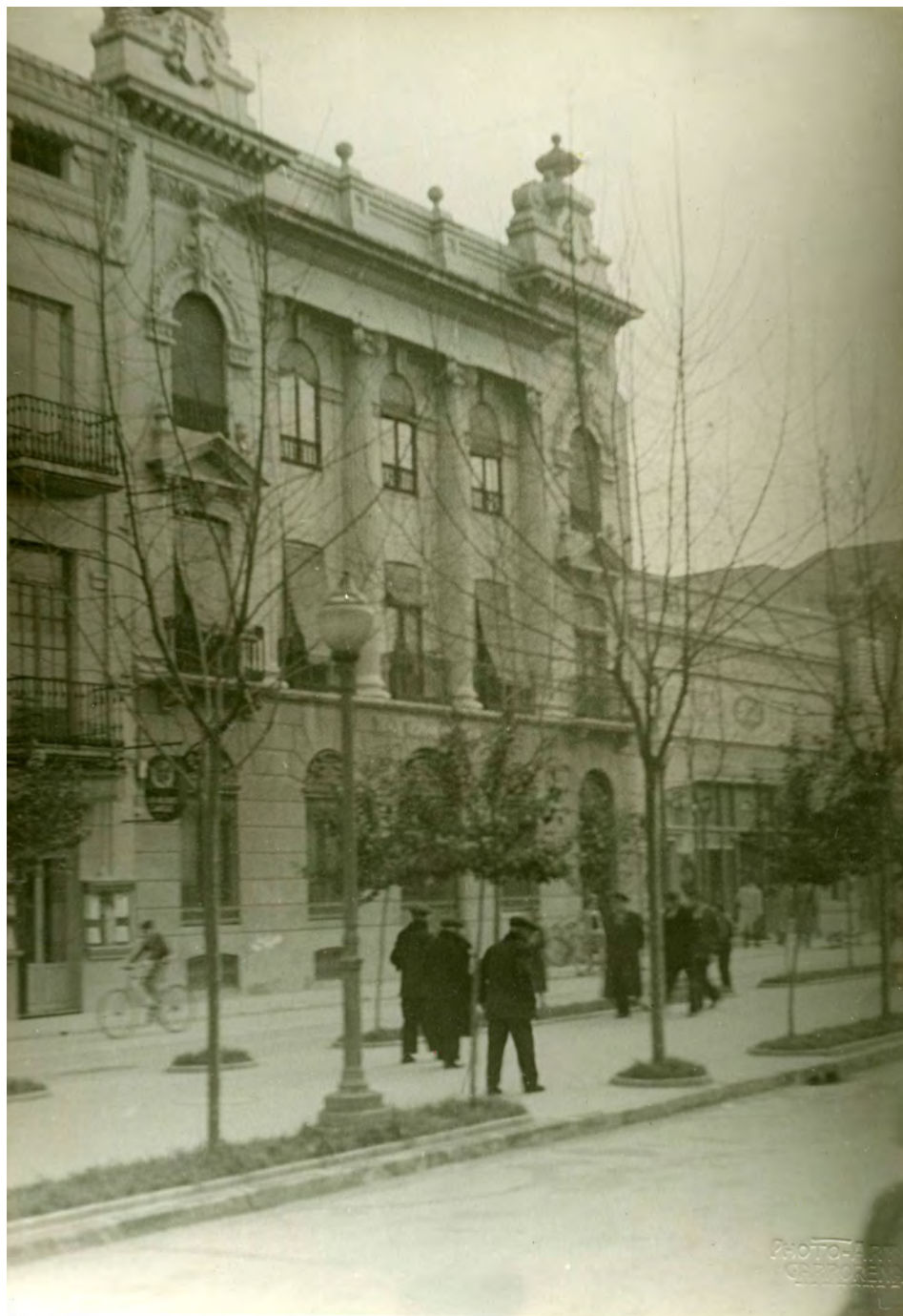
Fotografía 8. Vista del edificio colindante al negocio de Eduardo Navarro Armero, actualmente es un nueva edificación con la instalación de una entidad bancaria. Expediente para la inclusión ..... Fotografías en carpeta III nº. 1 AMAB, Leg 853.
