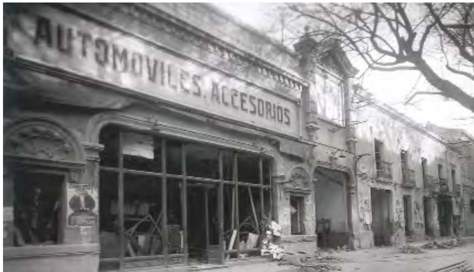
Fotografía 18. Fotografía de Antonio Alfaro. Según el propietario de la instantánea ésta fue tomada "después de un bombardeo" hacia 1937. Copia de la fotografía inserta en el Expediente Construcción de un garaje y sus dependencias anexas num. 102, en el Paseo de Alfonso XII, num. 4 .Proyecto de garaje - 02.04.1925 por Julio Carrilero - AMAB Planero 3-15.
