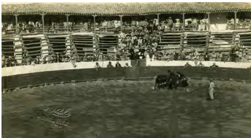
Foto de Pascual García (Royal). Feria de 1922. Charlotada a cargo de los toreros Lerín, Charlot y el Guardia Torero en la primera plaza de toros de la villa. Puede verse su estructura soportada a base de pies derechos con zapatas y sus asientos de tablancillo apoyados en burros de mampostería.
