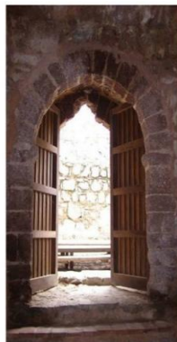
f).- Dependencias de servicio. Arco interior del acceso al horno.
