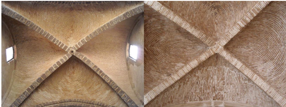
13. Bóvedas de crucería con plementería en “nido de golondrina” de la iglesia de Calatrava la Nueva (a) y de San Miguel de Brihuega (Guadalajara). (Foto: autor 2006)
