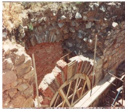
5).- El arco anterior en proceso de reconstrucción.
