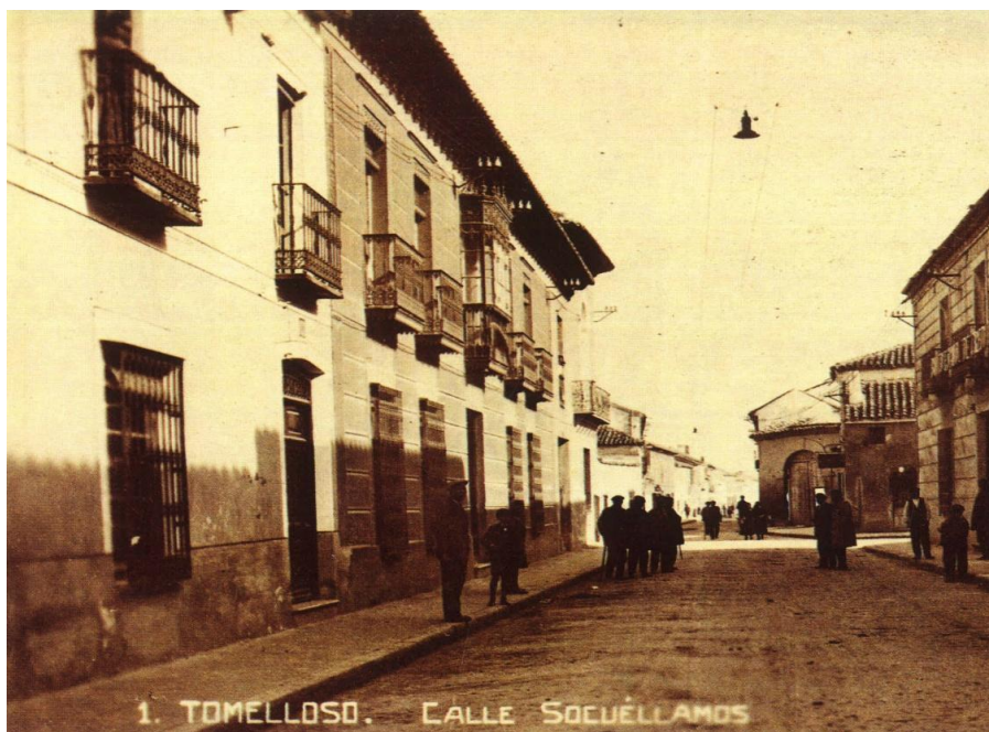
Figura 3. Balcón de estilo romántico. Calle Socuéllamos n 14. Principios del siglo XX. Actual edificio sindical, en Ibidem , pág. 39
