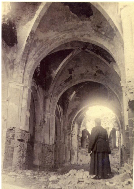
3. Interior de la iglesia antes de eliminar los revocos. (Foto: Portuondo, 1917)
