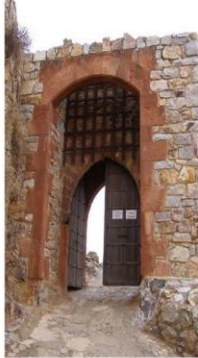
1).- Antemuralla. Puerta de los Arcos. Lado extramuros.
