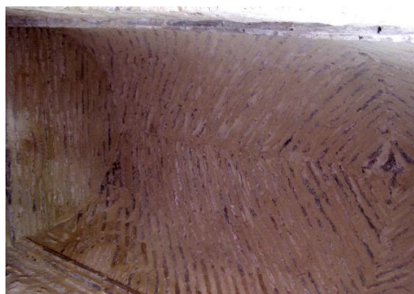
10. Bóvedas de cañón con las roscas dispuestas “a bofetón” en Calatrava la Nueva (izquierda) y castillo de Bolaños (derecha). Derecha: (Foto: autor, 2007)
