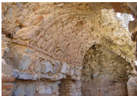
10. Bóvedas de cañón con las roscas dispuestas “a bofetón” en Calatrava la Nueva (izquierda) y castillo de Bolaños (derecha). Derecha: (Foto: autor, 2007)
