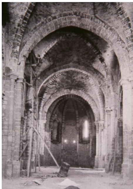
4. Interior de la iglesia con los andamios montados para terminar de eliminar revocos a comienzos de la década de 1950
