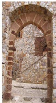
7).- Puerta de la clausura de la por la parte de la iglesia.
