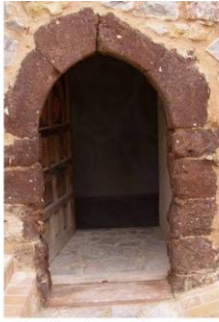
h).- Castillo. Acceso bóveda segunda planta.
