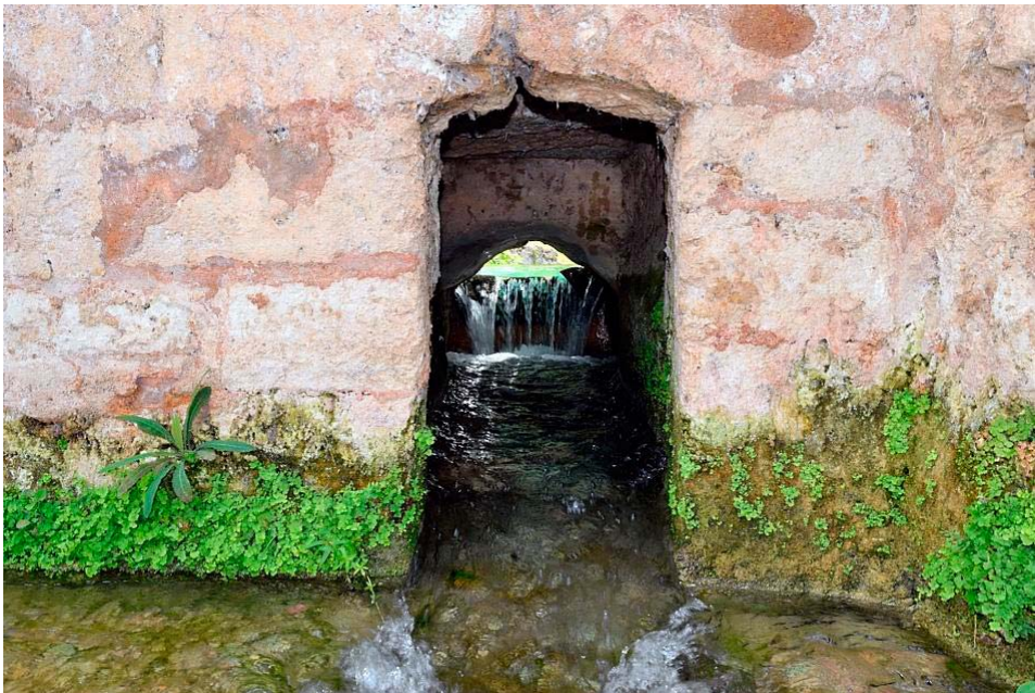
Figura 7: Detalle de uno de los canales de la Compuerta Real de Ruidera. Fuente: Foto del autor
