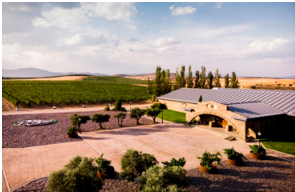
Figura 24. Bodega Finca Río Negro (Fotografía cedida por la bodega).
