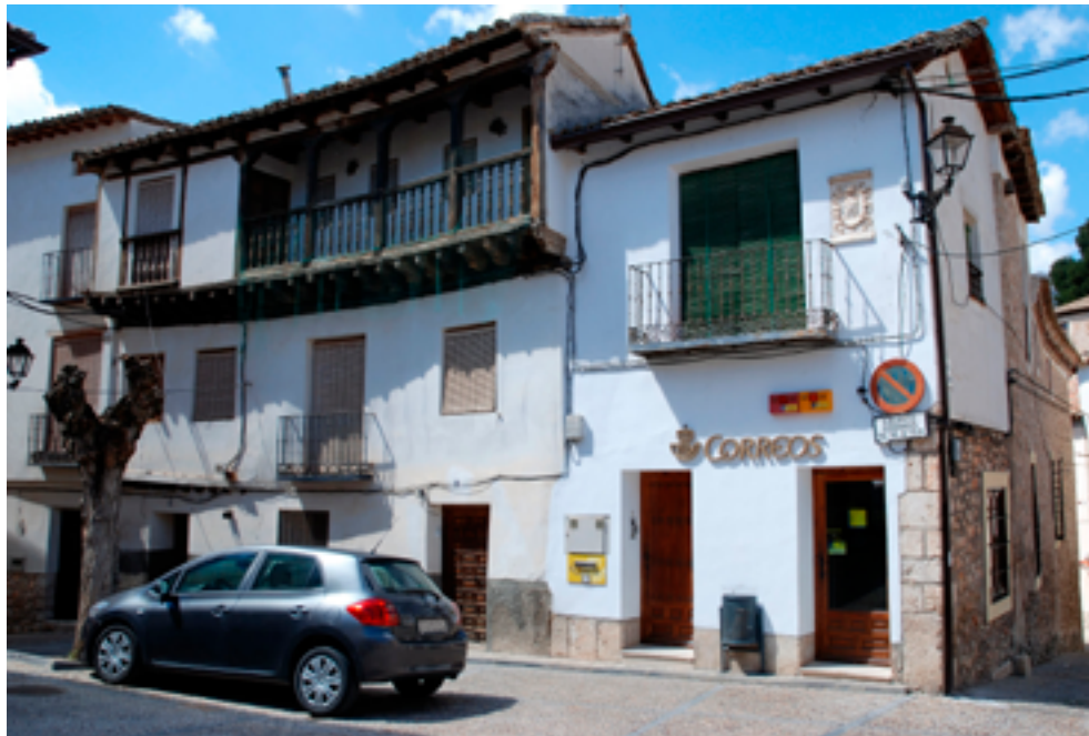
Palacio de los Muelas. Fachada actual
