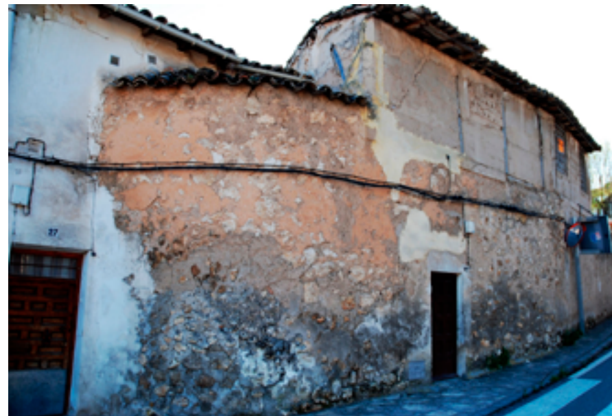
Fachada posterior. Adosados. Muralla
