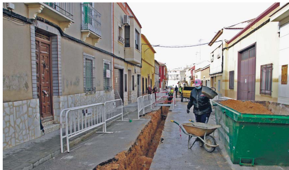
LAS OBRAS DE LA CALLE CUBEROS /M.G.
