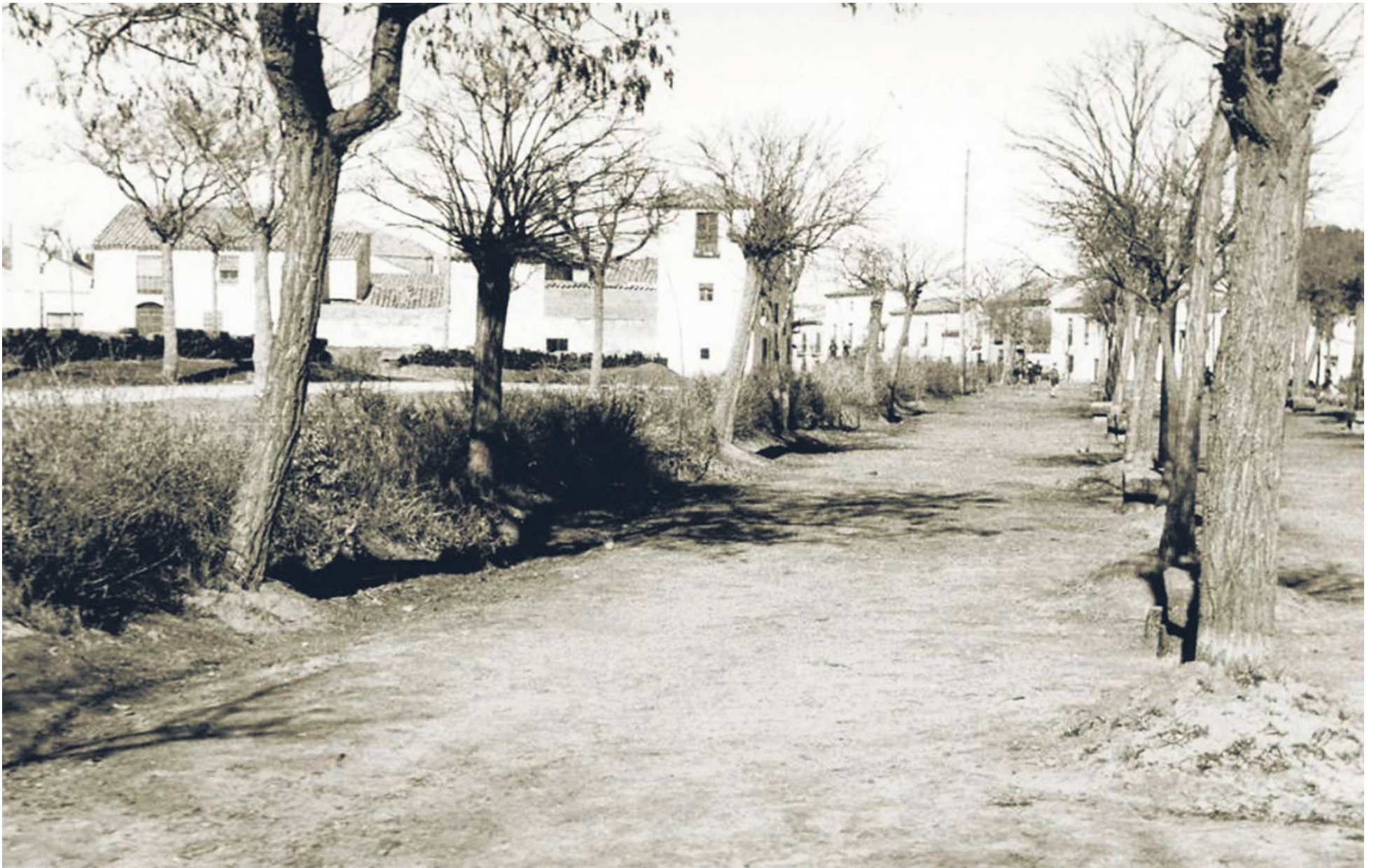
El Paseo de Villanueva de los Infantes construido sobre el antiguo cementerio de San Juan
