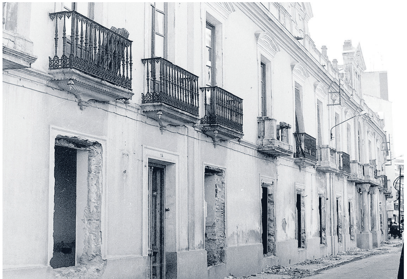
Imagen de la demolición de la Audiencia
