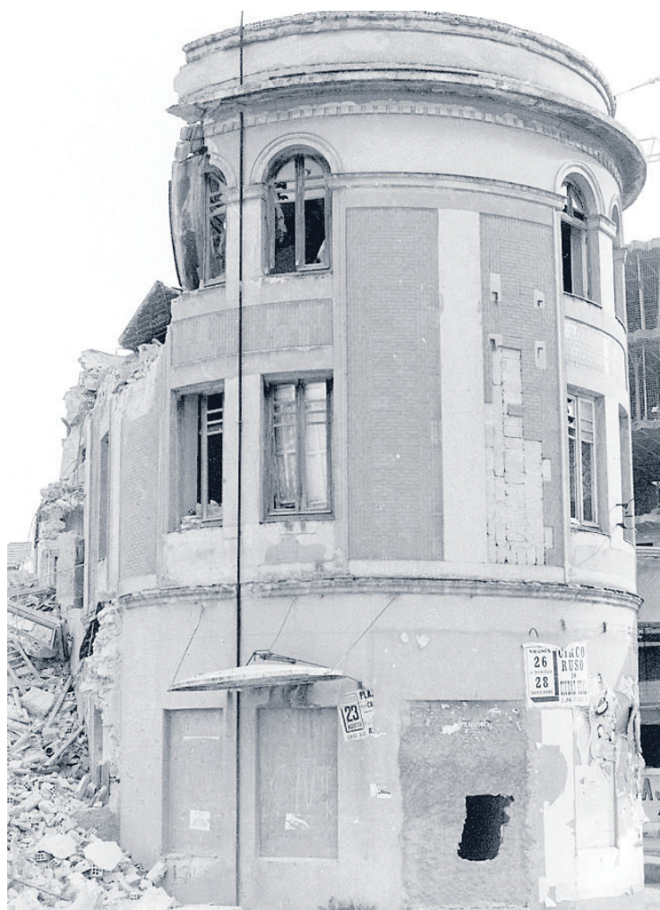
Imagen de la demolición del garage Ford
