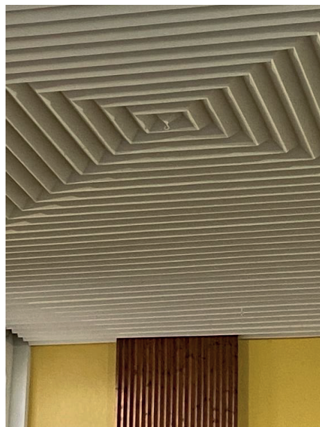
Alzado actual y detalle del techo. DPS 2022
