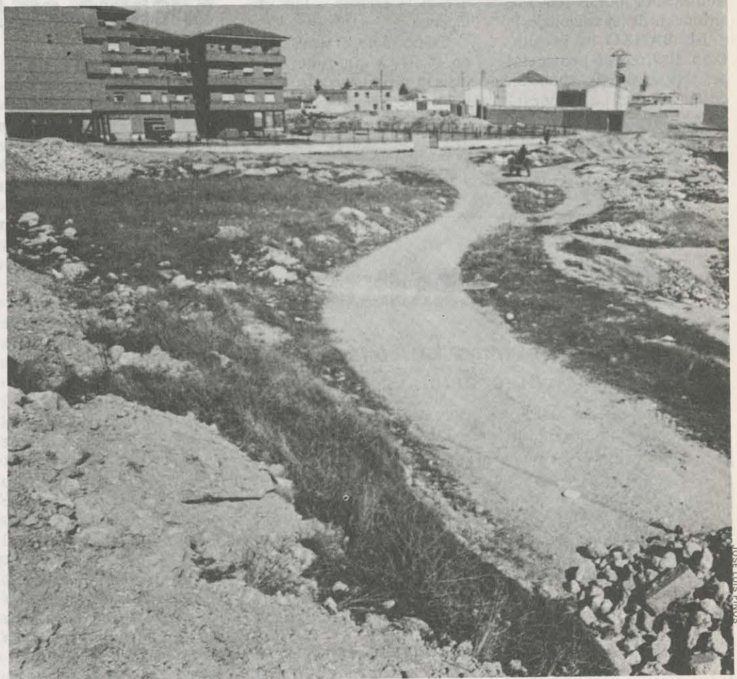
AQUI DEBERIA ESTAR CONSTRUYENDOSE LA RESIDENCIA
