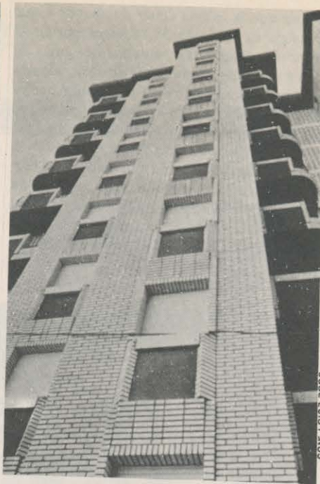
LOS CABLES ESTAN PUESTOS. PERO LA LUZ NO LLEGA.
