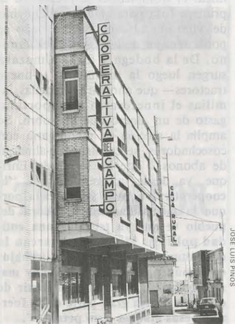
EN EL MISMO EDIFICIO, LA COOPERATIVA TIENE SU SEDE Y LA DE LA CAJA RURAL
