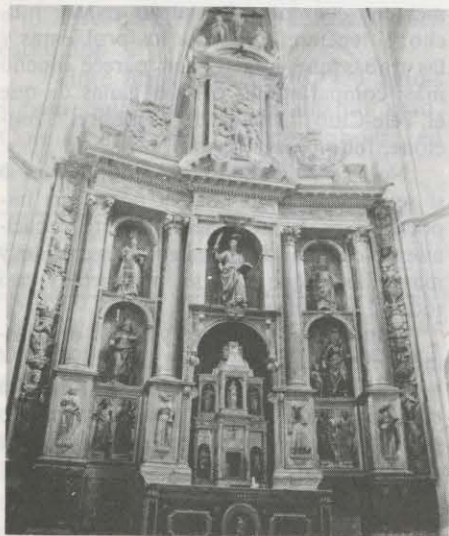
ESTE RETABLO HA SUFRIDO YA GRAVES DAÑOS... Y PUEDEN SER MAYORES SI NO SE ACTÚA CON RAPIDEZ
