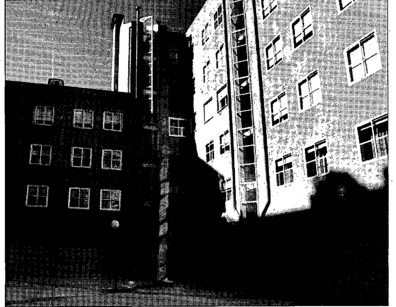
Estado actual de los patios interiores./TIN BIJAKSIC
