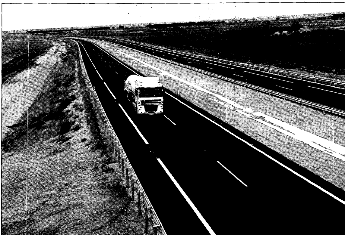
García señala que no se cumplirán los plazos dados para finalizar las infraestructuras./LA TRIBUNA
