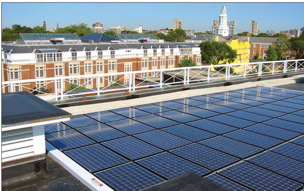
Las nuevas normativas en el sector de la construcción de la Tercera Revolución Industrial crearán una floreciente economía, generando millones de empleos. Foto: Paneles solares en viviendas.
