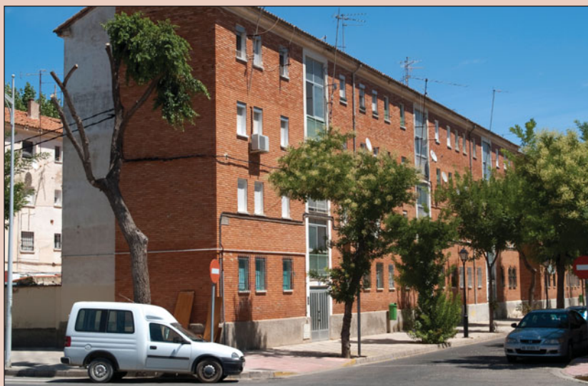
La subvención para la rehabilitación por vivienda será del 25% del presupuesto protegido.
