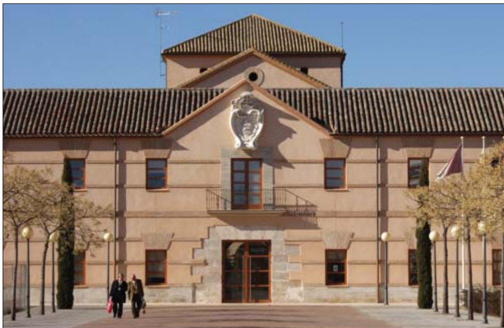
Edificio del Rectorado de la Universidad de Castilla-La Mancha en Ciudad Real.
