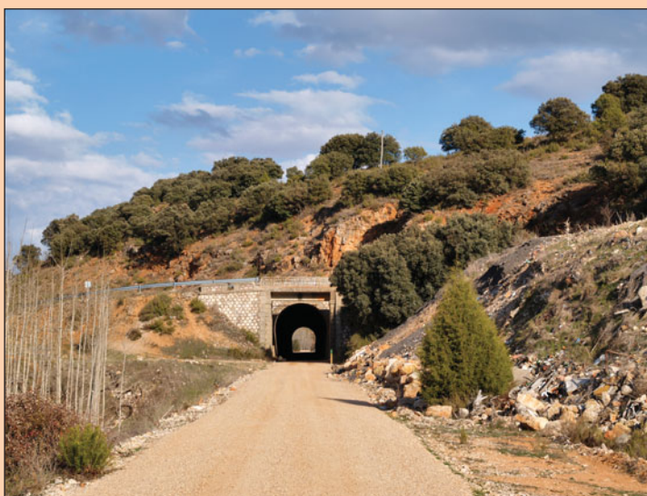
Antiguo puente de ferrocarril Baeza-Utiel, sobre la Vía Verde. Nunca llegó a utilizarse.
