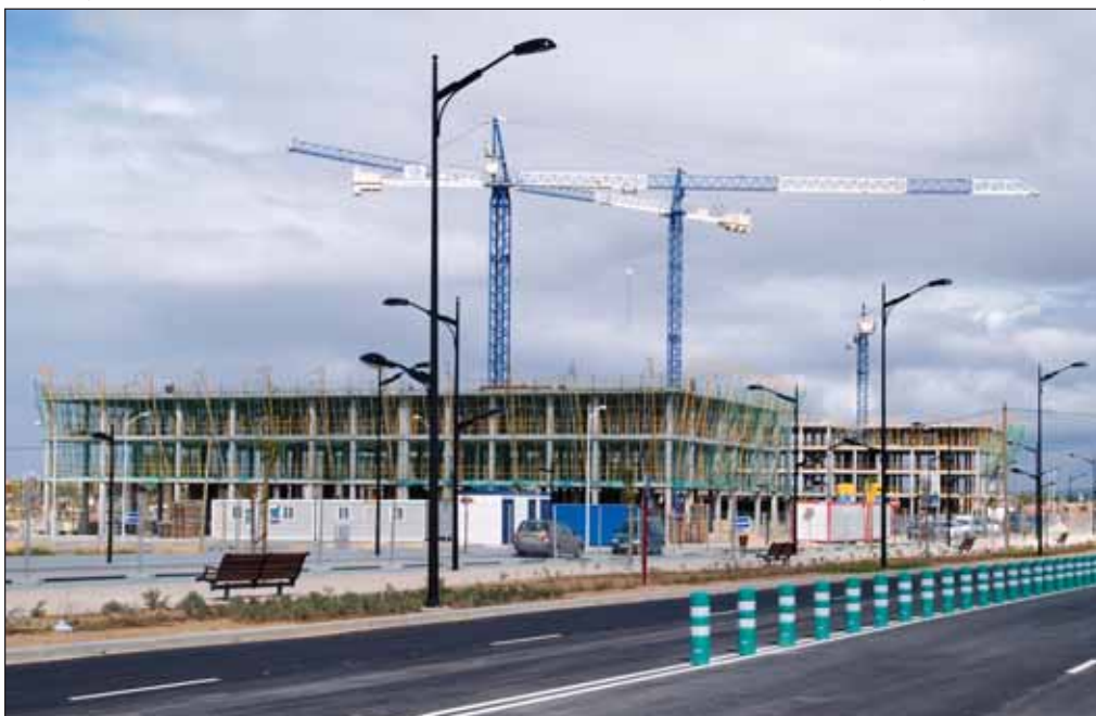
El Consejo de Ministros también aprobó el Real Decreto de Instalaciones Térmicas de Edificios (RITE).
