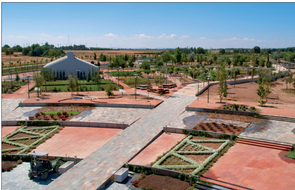
Vista panorámica de una parte del Jardín Botánico de Castilla-La Mancha, todavía en proceso de construcción.
