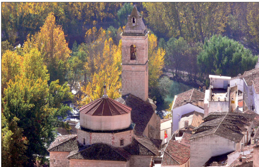
La construcción del templo de la Iglesia de San Andrés se inició en el siglo XVI y finalizó en el XVIII.
