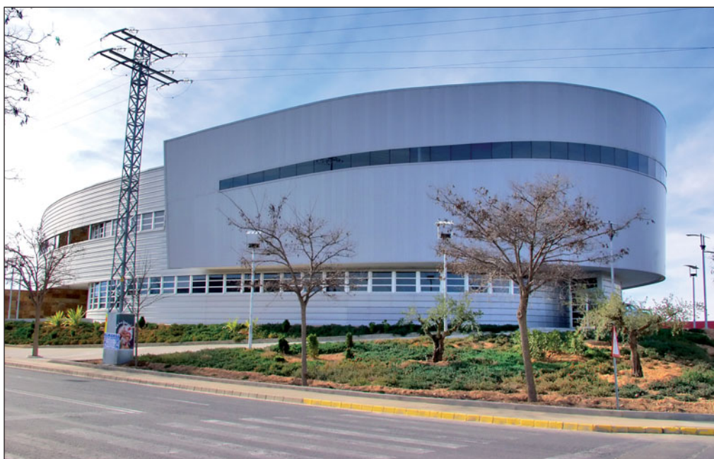
Centro de Innovación y Desarrollo Empresarial (AIDECA), en el Polígono Industrial de Almansa.
