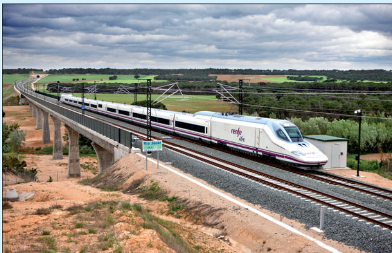
La nueva infraestructura ha sido construida con los parámetros más exigentes de calidad y seguridad, convirtiéndose en un verdadero reto de ingeniería ferroviaria. Foto: AVE-S112
