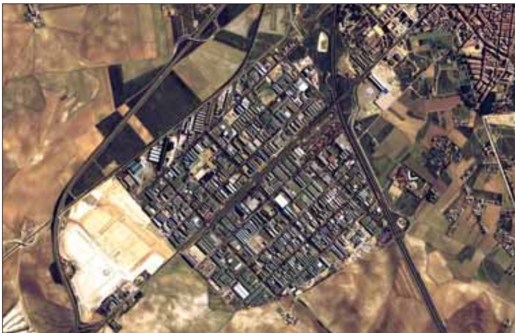
Vista aérea del Polígono Industrial Campollano en Albacete.
