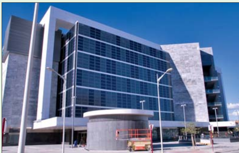
El nuevo centro dispone de módulos fotovoltaicos para producción de energía eléctrica limpia.
