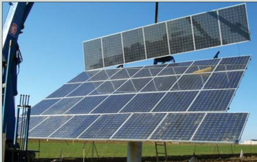
La energías renovables son unas de las grandes esperanzas para el despegue industrial de Almadén.
