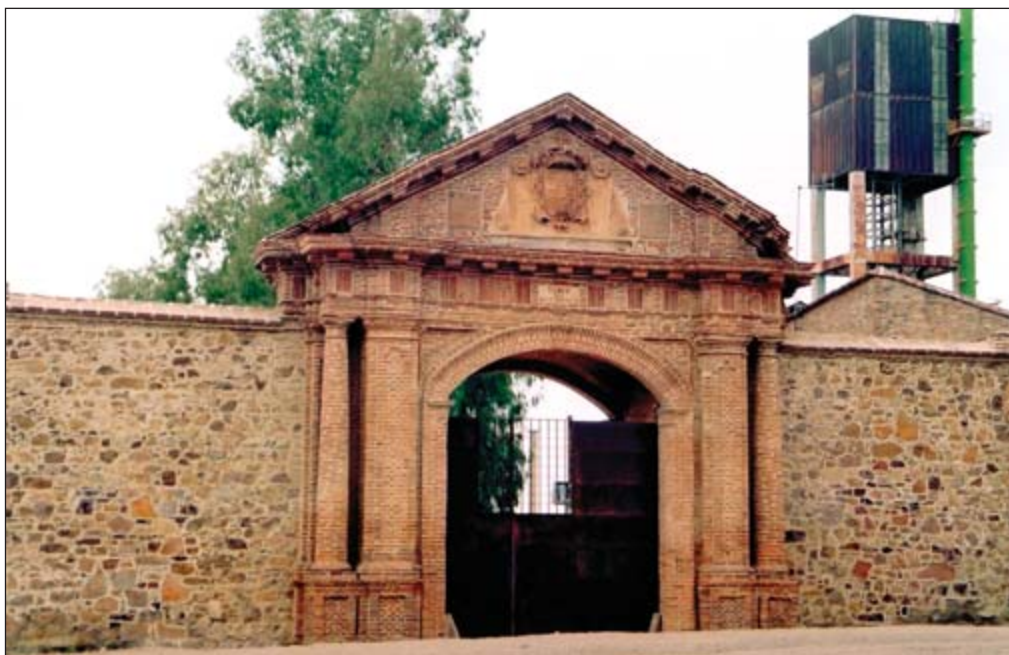
Puerta de Carlos IV que da acceso al Cerco de Buitrones, según la fecha que figura en una inscripción data de 1795.
