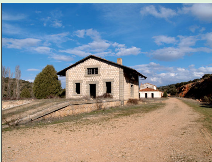
Antigua estación de ferrocarril Baeza-Utiel, actualmente convertida en Vía Verde.
