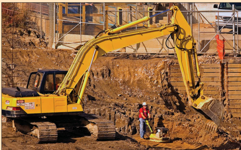
A nivel regional, los recursos de la consejería de Ordenación del Territorio y Vivienda crecerán un 2,56% el próximo año con el objetivo de suavizar el descenso de la actividad en la construcción.
