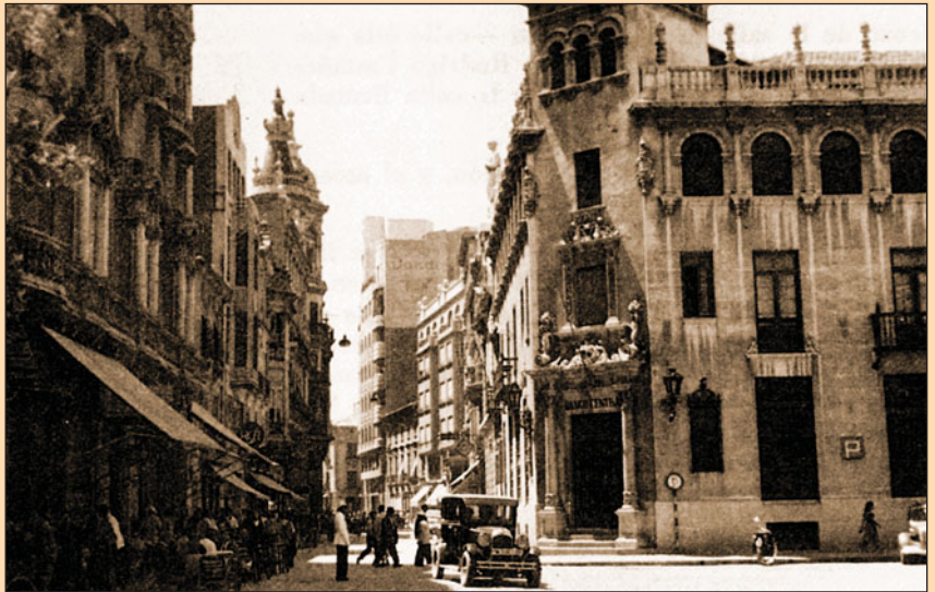
Antiguo edificio del Banco Central (demolido) en la calle del Marqués de Molins, enfrente, el edificio del Gran Hotel.
