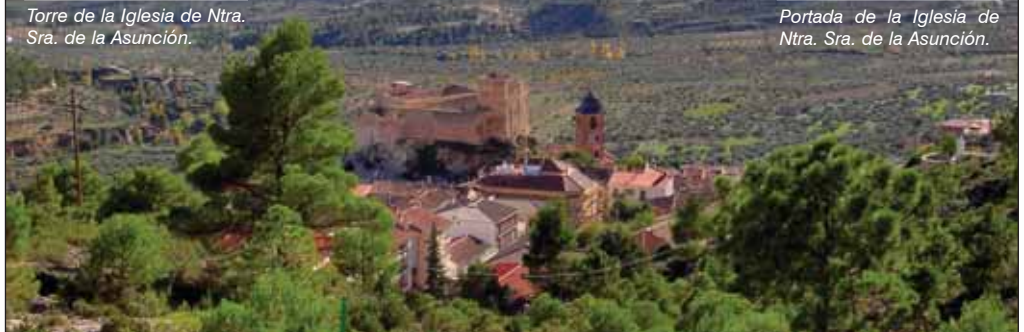
Vista de Yeste con el Castillo y la Iglesia como monumentos a resaltar.
