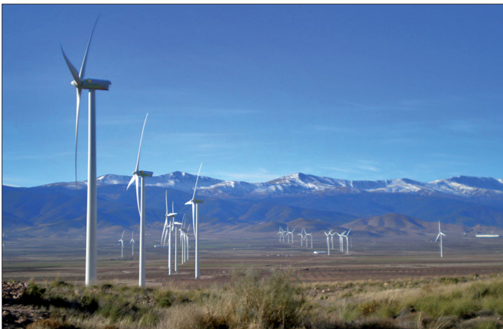
La UCLM apuesta por la energía renovable y la protección del medio ambiente. Foto: Parque eólico El Marquesado (GU).
