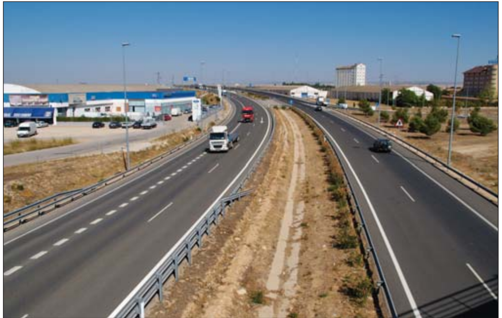
El desarrollo de nuevas infraestructuras permite acercar la población y las mercancías, generando riqueza en su entorno.
