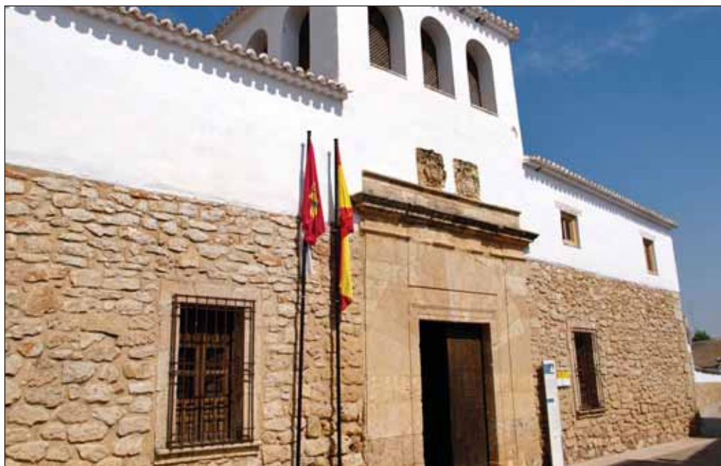
El edificio, conocido hoy como Casa-Museo de Dulcinea, fue adquirido por el ministerio de Educación para restaurarlo.
