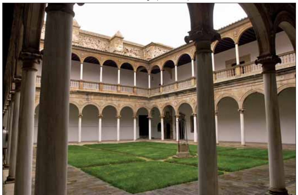
Claustro del Convento de la Asunción de Calatrava en Almagro (Ciudad Real).
