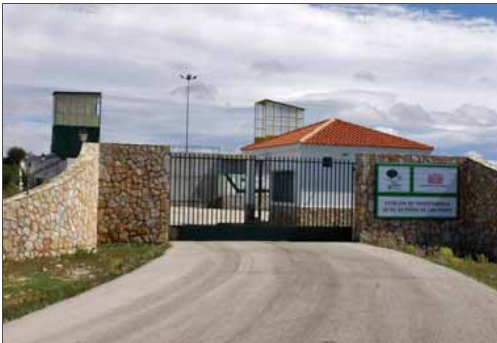
Estación de Transferencia de RU de Peñas de San Pedro (Albacete).
