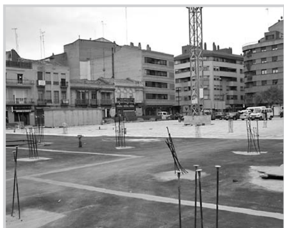
Exterior del aparcamiento.
