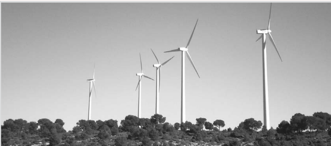
Parque eólico de Chinchilla.
