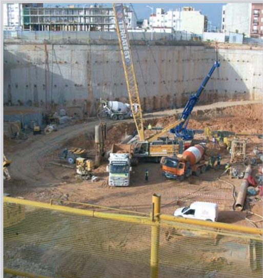
Obras de El Corte Inglés.
