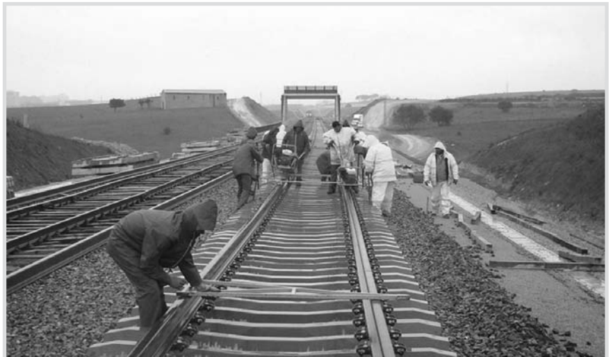
Obras en la línea del Ave Madrid-Levante.
