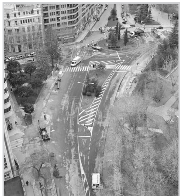
Vista de las obras del aparcamiento.
