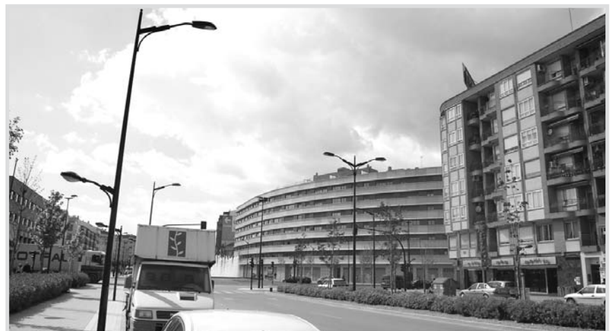
Capitán Cortés con Circunvalación, a la altura de la calle del Rosario.
