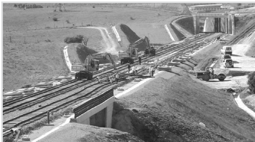
Obras en las vías del Ave.
