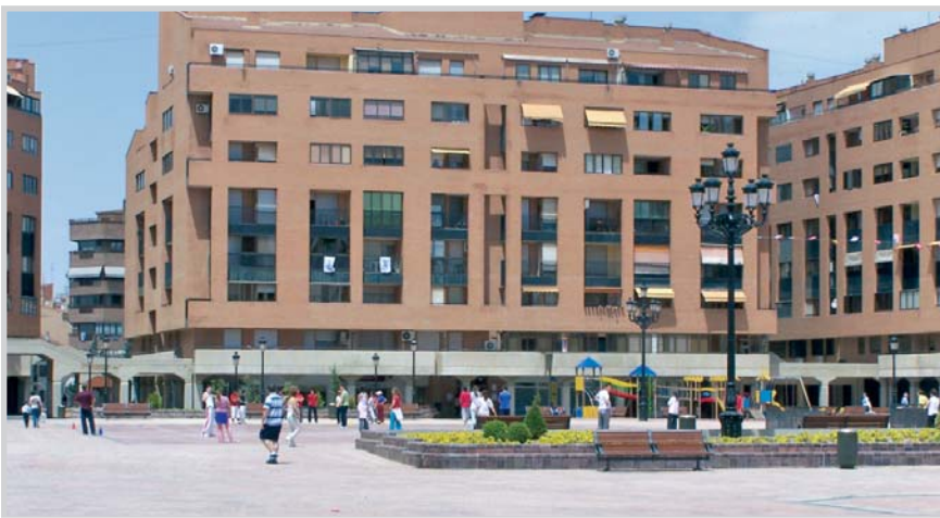
Aspecto de la nueva plaza de Villacerrada, tras las obras.
