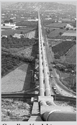
Canalización del trasvase.
