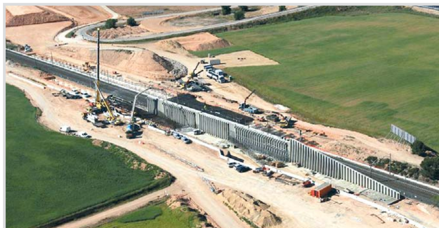
Construcción de la pérgola que dividirá las vías de ancho ibérico y ancho convencional hacia Levante.
