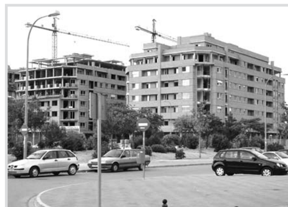
Viviendas de VPO en construcción.
