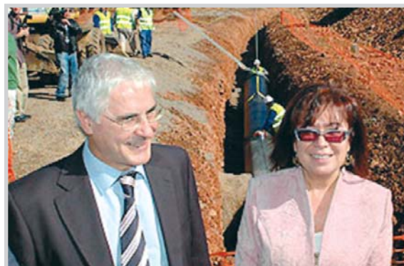
José María Barreda y Cristina Narbona durante su visita a las obras de la tubería de abastecimiento.
