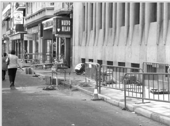
Obras en el Paseo de la Libertad.
