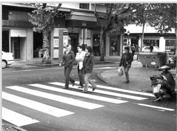
Asfaltado en la calle Bernabé Cantos.
