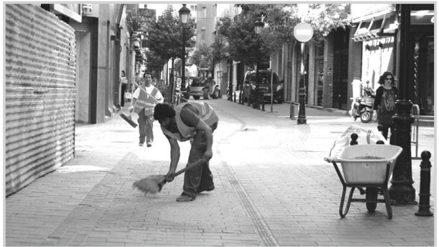
Adoquinando, en la calle Gaona.
