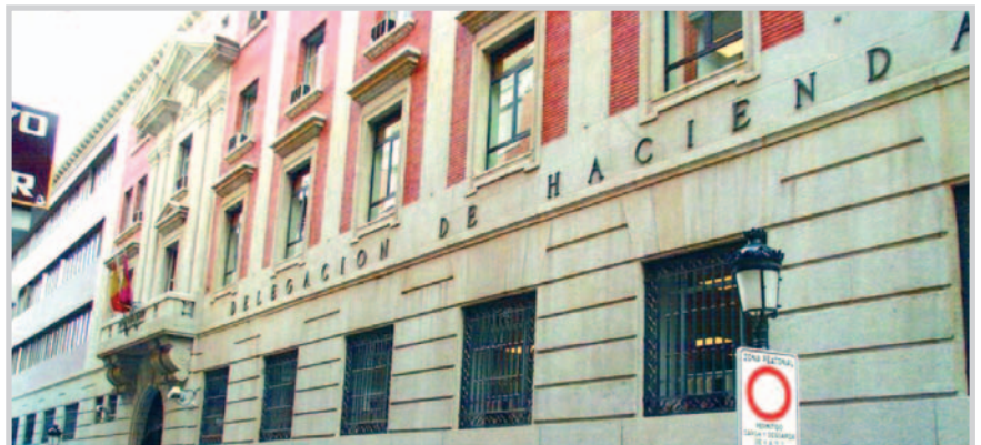
Edificio de Hacienda.
