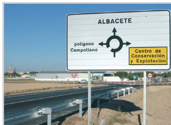
Imagen del acceso sur al polígono.
