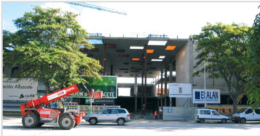
Obras de la estación del Ave.
