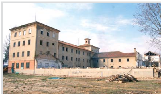
Estado de las obras del Giner de los Ríos.
