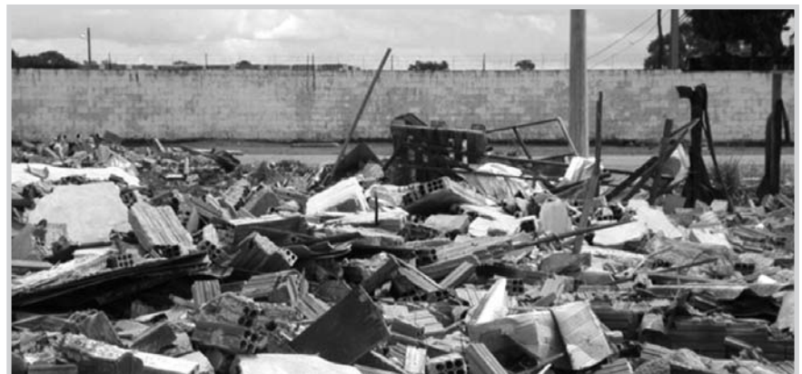
Escombros de construcción.
