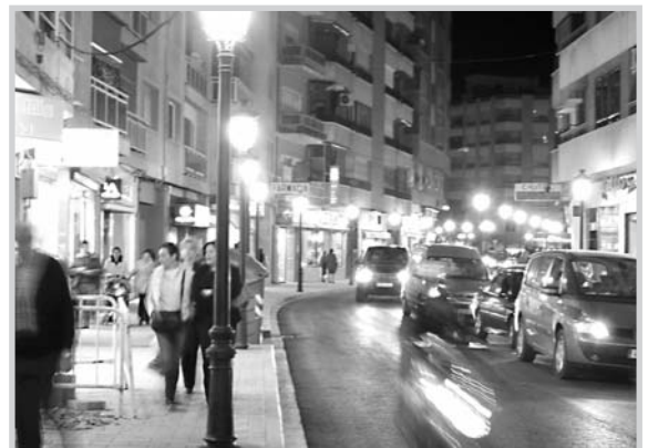
La calle del Rosario, casi finalizada; a la izquierda, una pequeña obra.
