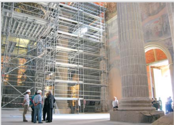
La Catedral, en obras.
