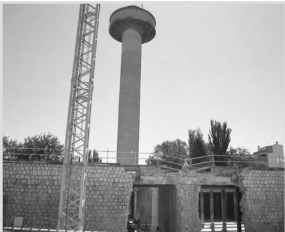
Obras Depósito Fiesta del Árbol.
